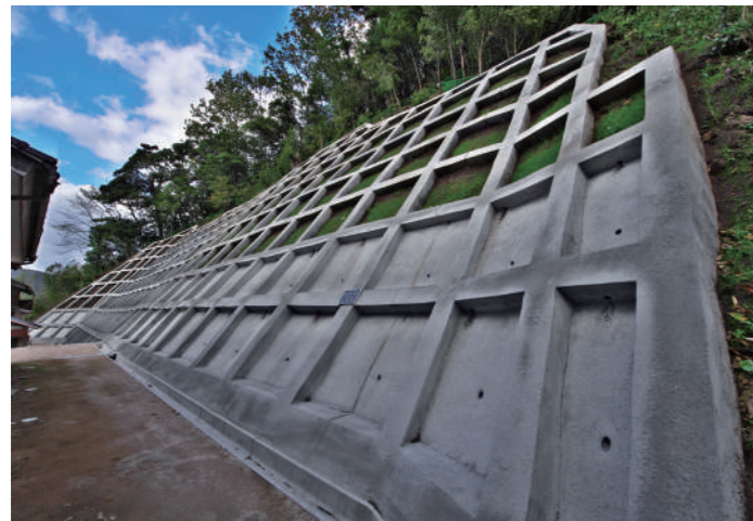
▲モリタ工業が得意としている斜面の法面保護工事は自然災害を防ぐための重要な業務です
